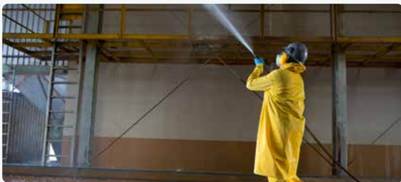
Limpeza das paredes e teto dos silos
