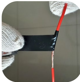
Emenda que requer fita isolante
