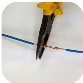
Emenda de continuidade com fio rígido
