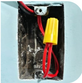
Emenda com conector, que não requer fita isolante
