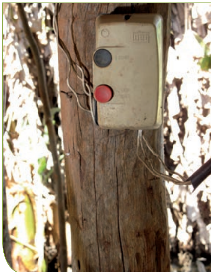
Instalação elétrica mal feita
