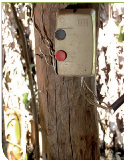
Instalação elétrica mal feita
