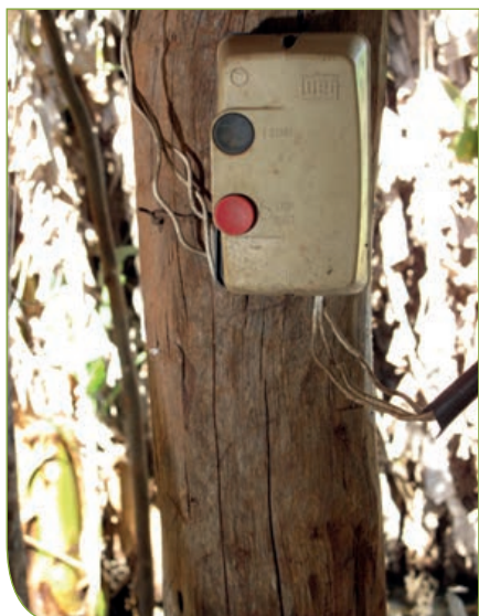
Instalação elétrica mal feita
