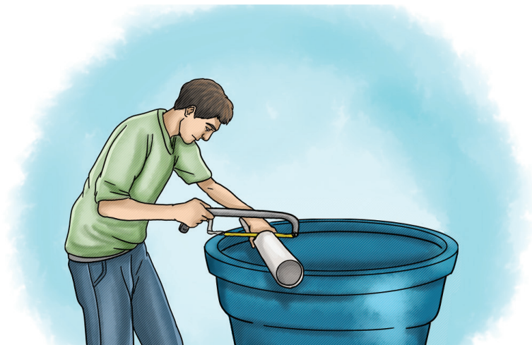
Serre os canos e conecte-os nas caixas
